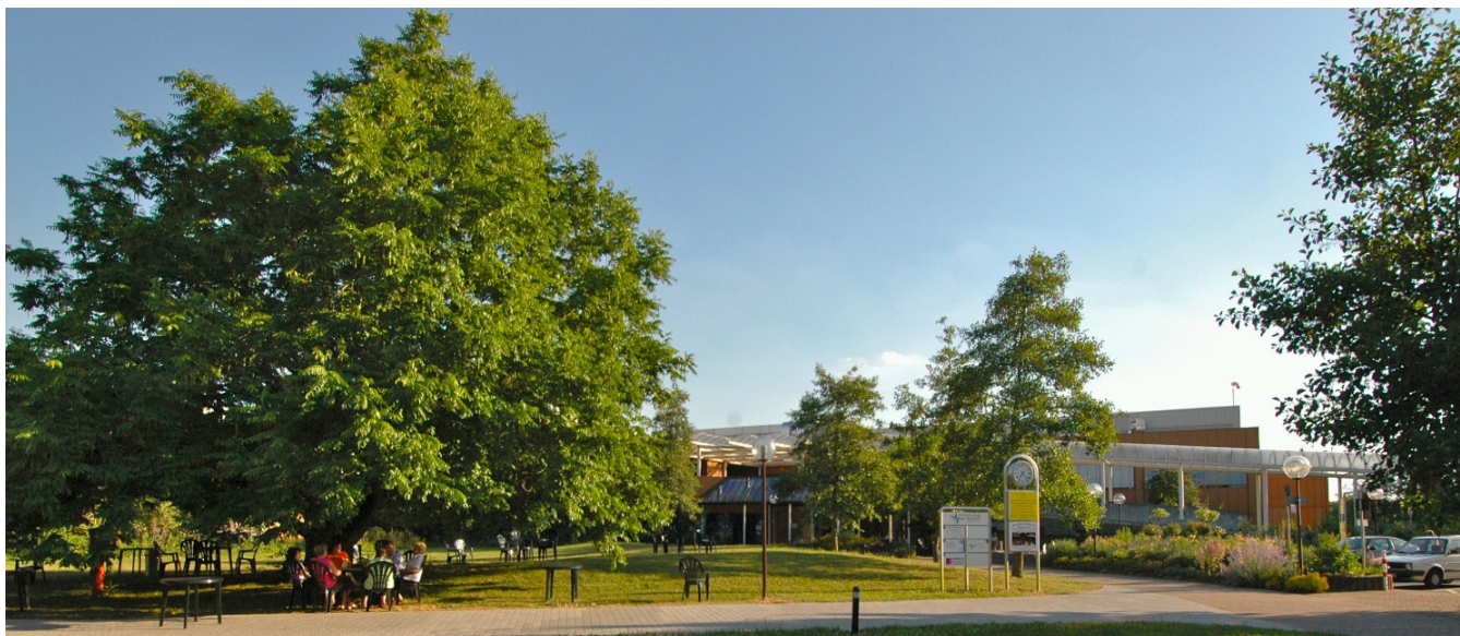
Abbildung: Kreis Krankenhaus Bergstraße gemeinnützige GmbH
